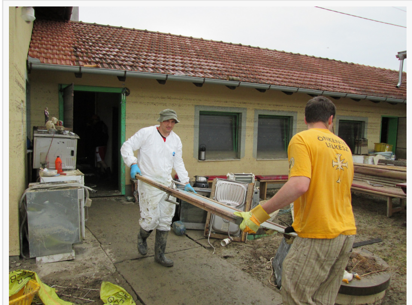
AUFRÄUMARBEITEN IN HÄUSERN
