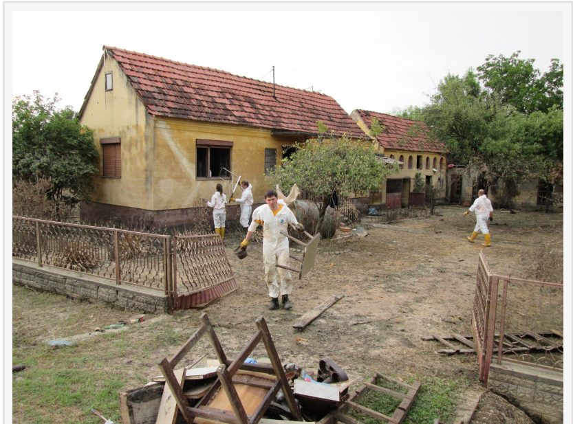
AUFRÄUMARBEITEN IN HÄUSERN
