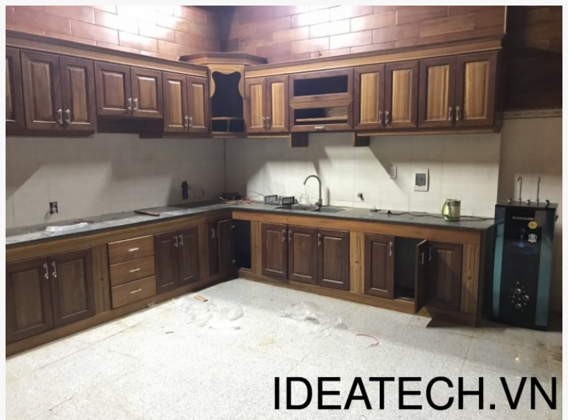
Lắp Đặt Điện Thông Minh Cho Biệt Thự Gỗ Tại TPHCM
