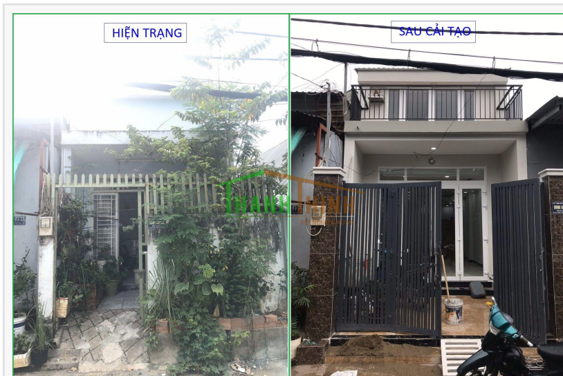
Công trình thực tế trước và sau thi công trần Cemboard tại TPHCM
