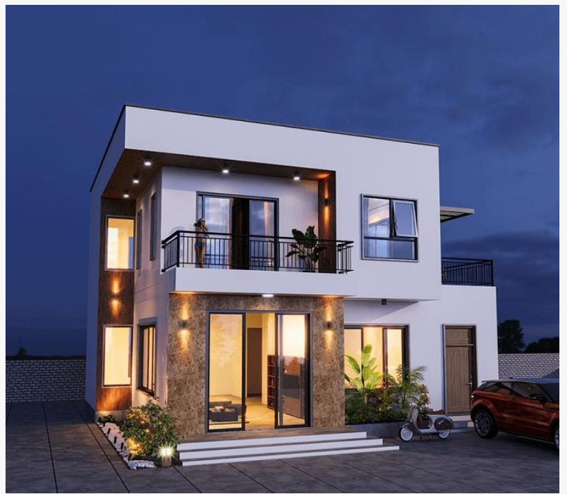
Chuyên xây dựng nhà phố trọn gói tốt nhất Quận 1
