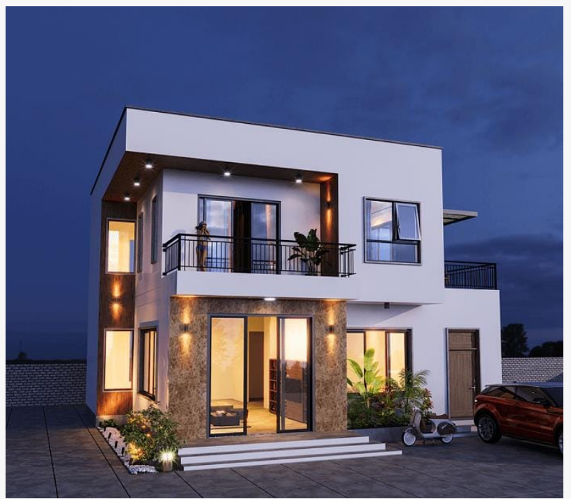
Chuyên xây dựng nhà phố phần thô hoàn thiện Quận 9
