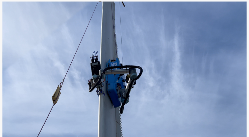
La herramienta dispensadora patentada está reconstruyendo y alisando después de la preparación de la pala del rotor.
