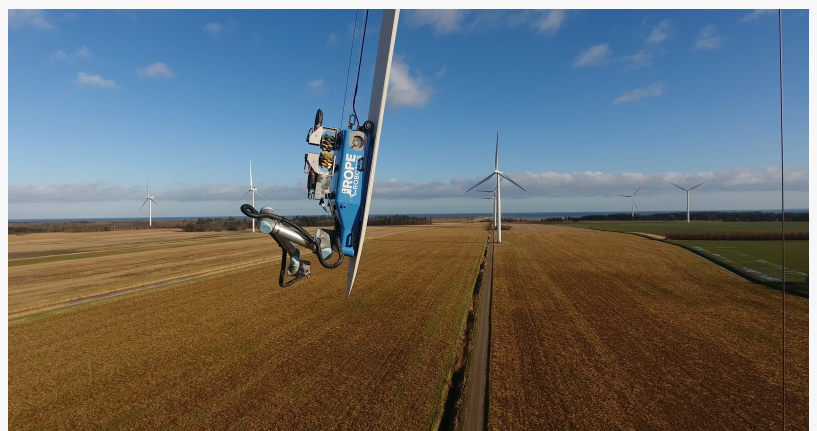
El robot puede transportar hasta ocho herramientas para reparar la pala del rotor del aerogenerador
