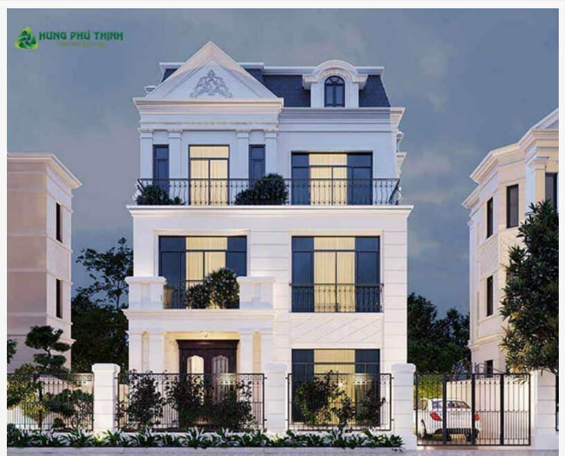
Bảng Đơn Giá Xây Dựng Nhà Trọn Gói TPHCM
