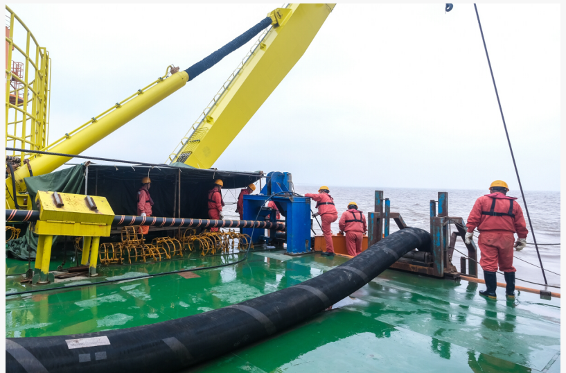
Tendido de cables submarinos
