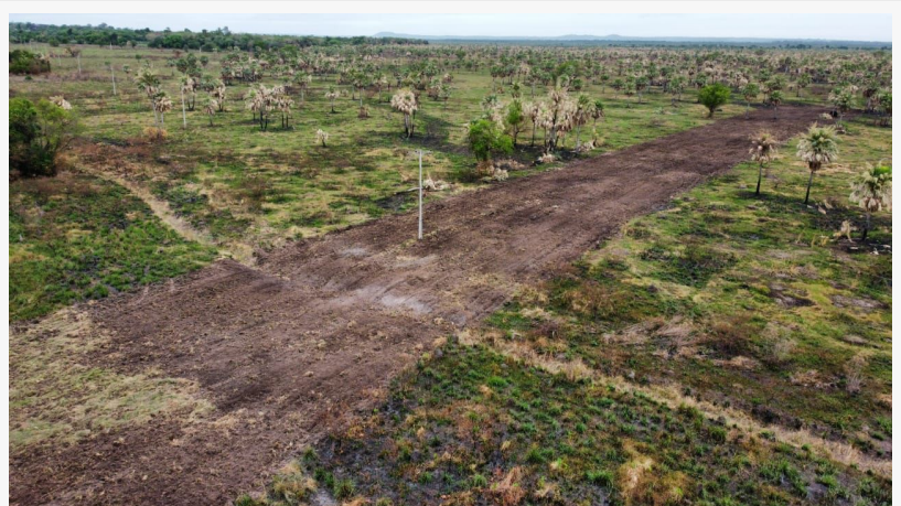
Die Bauarbeiten am Aldera Resort haben begonnen.
