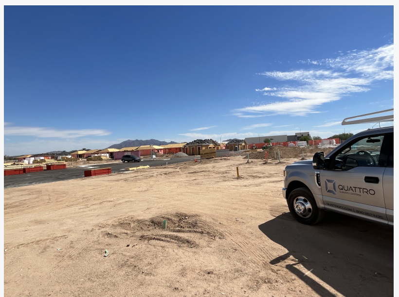
Quattro on-site at El Cidro
