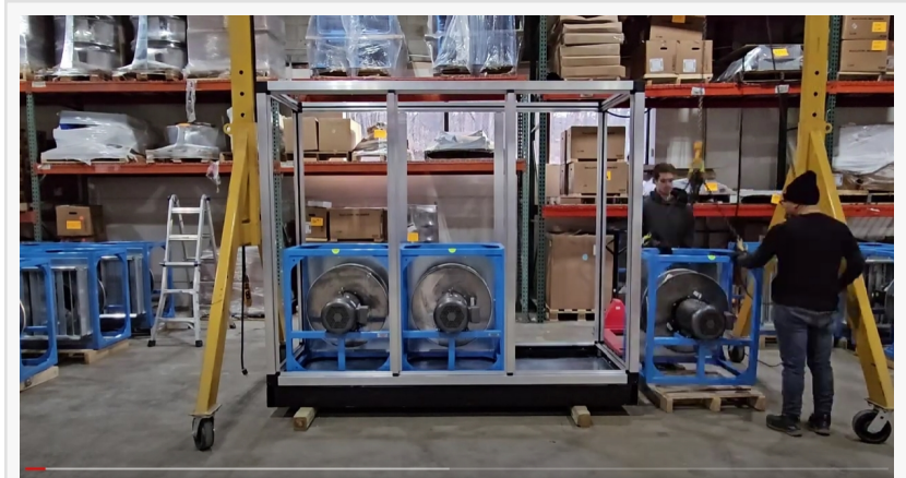
Fan Array Installation
