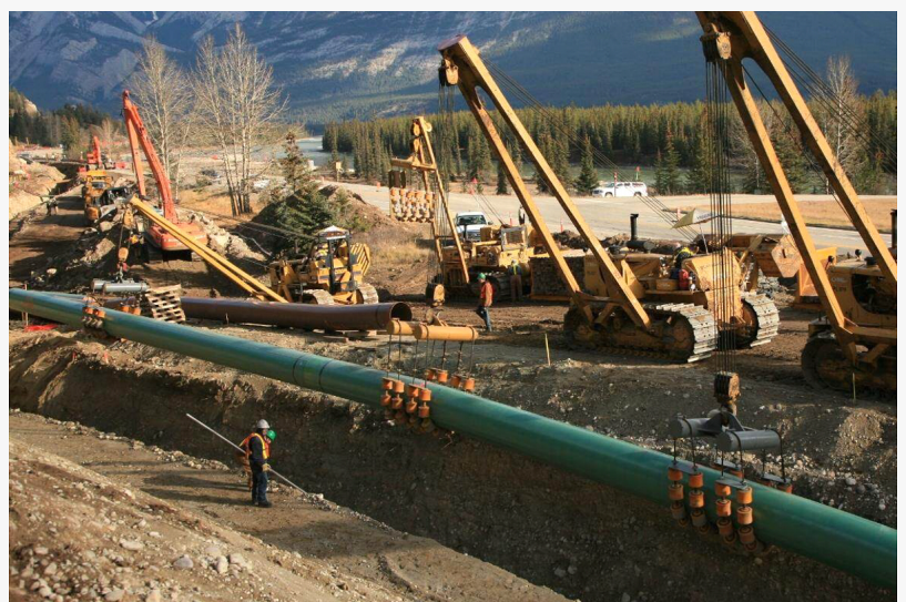
Construcción del Proyecto EACOP
