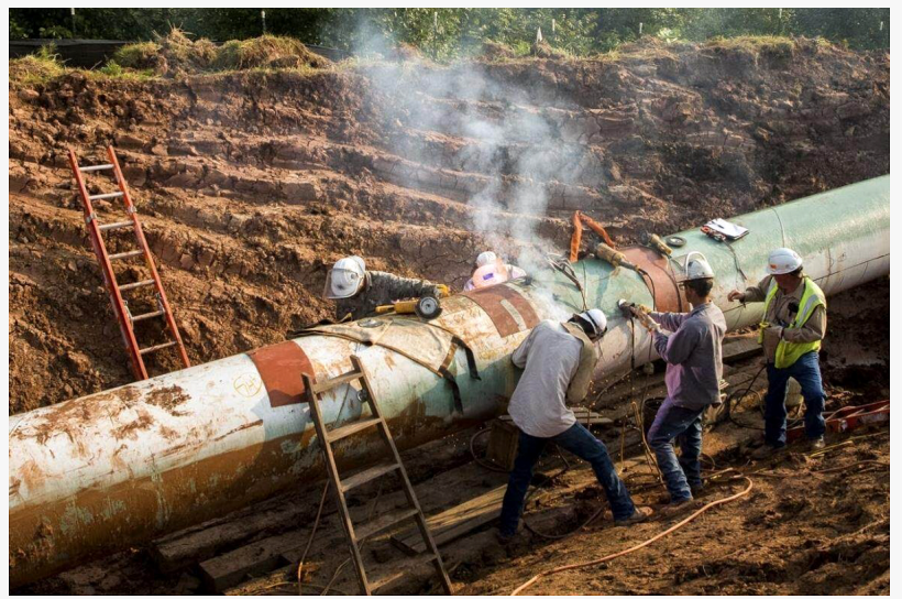
Obra del proyecto EACOP
