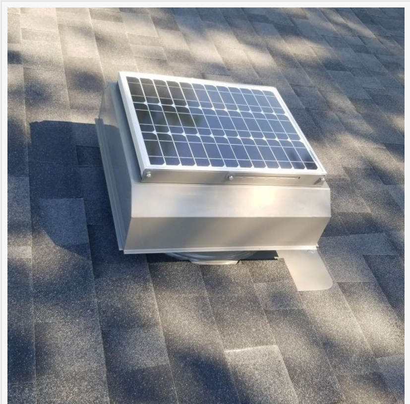
Solar Attic Fan
