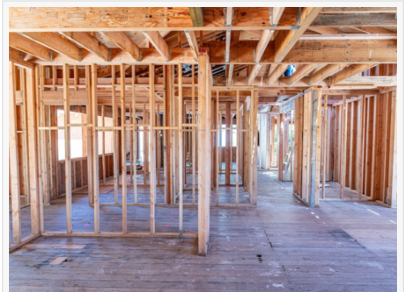
Los Altos House Rebuild
