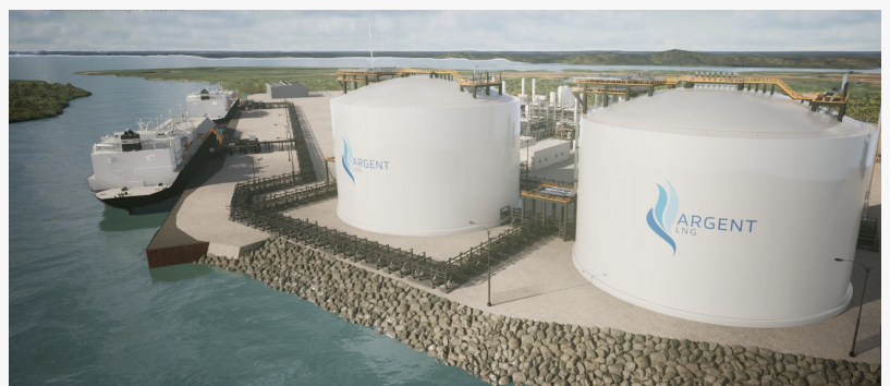
GTT Cryogenic Membrane LNG Containment Tanks
