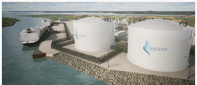
GTT Cryogenic Membrane LNG Containment Tanks
