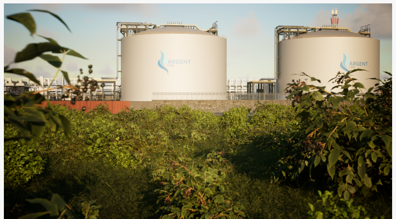
Argent LNG GTT Tanks 2
