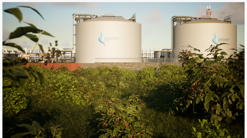
Argent LNG GTT Tanks 2
