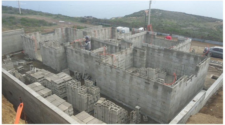
Estructura Casa Incablock BotBlocks - Ensenada, BC
