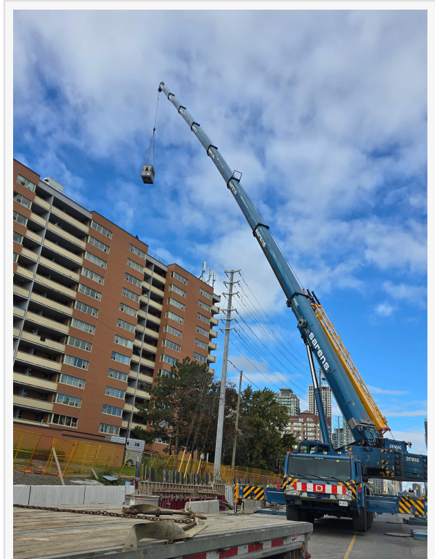
Sarens AC 220 crane
