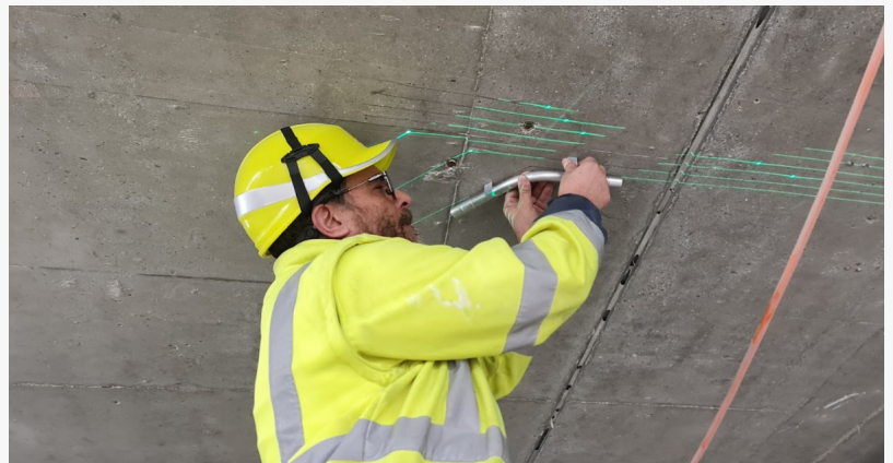
Projection laser au plafond avec le Projecteur XR
