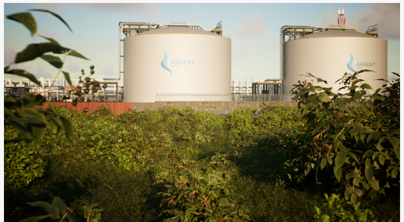
Argent LNG GTT Tanks 2
