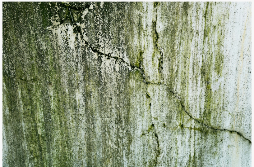
Gefährlicher Schimmelwachstum an Gebäudefassaden
