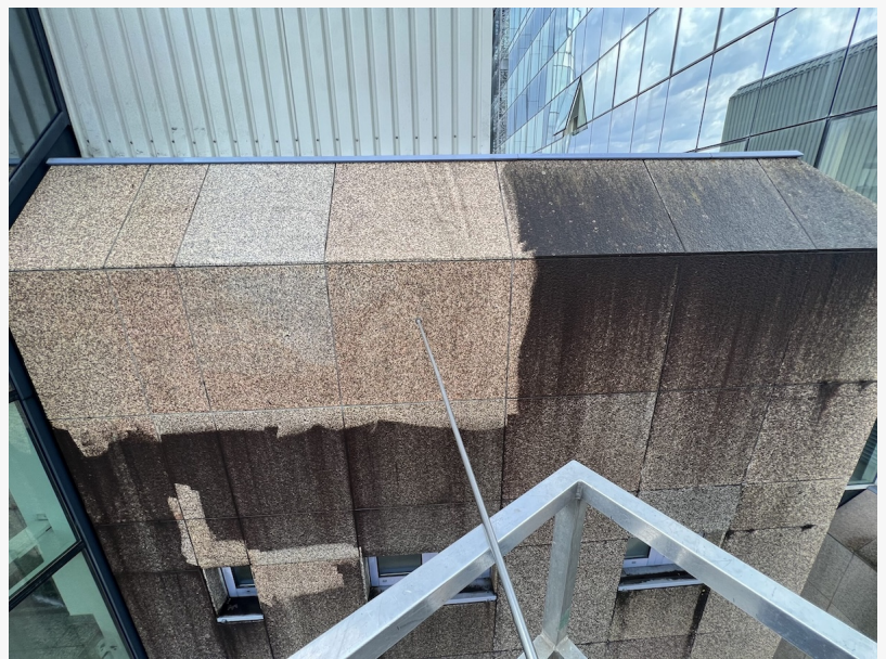
Vergleich Fassadenreinigung vorher nachher
