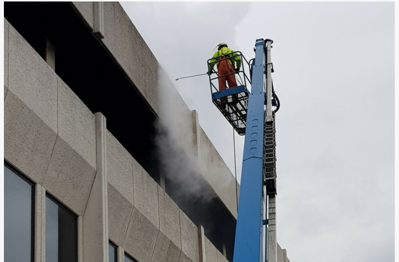
Fassadenreinigung ohne Hochdruck
