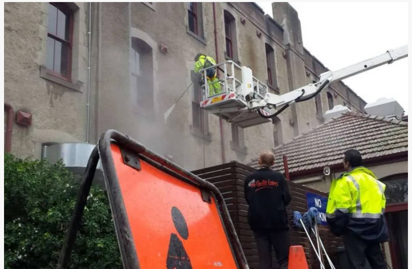
Hochdruckreinigung von Fassaden
