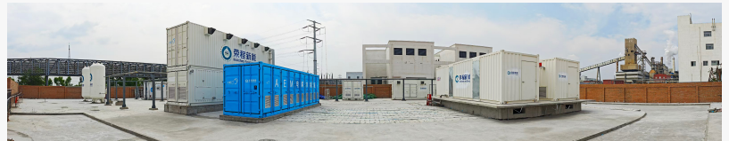
HET 5MW AEM Electrolyser Site Installation
