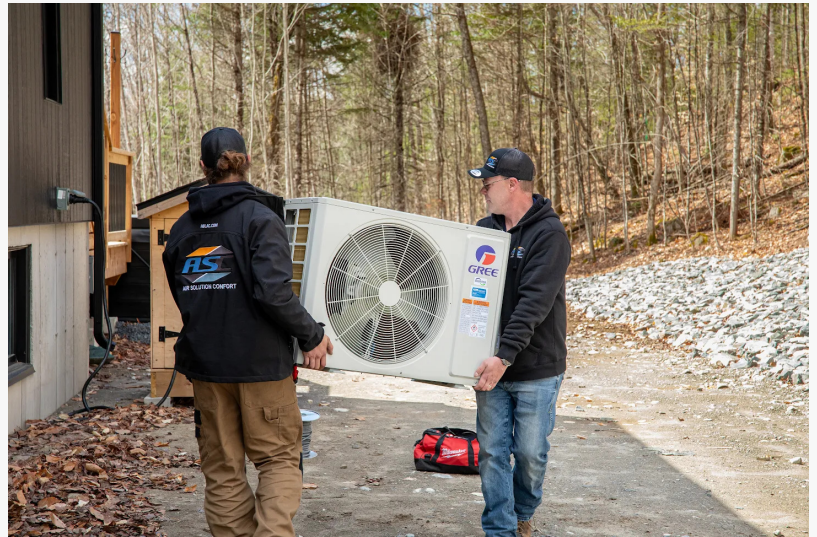
Deux techniciens d'Air Solution Confort installent une thermopompe murale GREE près d'un chalet en forêt, dans Lanaudière.
