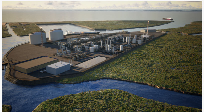
Argent LNG Back View
